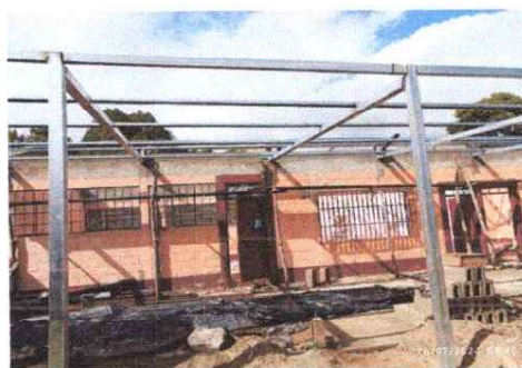
Foto 4: Techado aún sin canales, avance en colocación de costaneras
