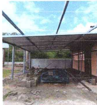
Foto 2: . Avance en la colocación de entechado (tres aulas, corredor, pasillo y cocina.)
