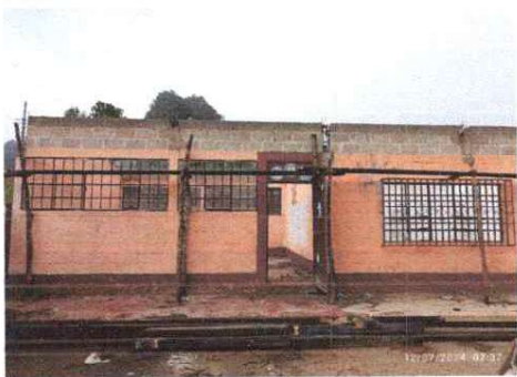
Foto1: Modulo 2: Avance en el levantado de tres hiladas de block a las aulas.
