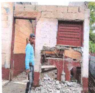
Foto 6: Modulo 6: La puerta y la pared de cocina frontal en remodelación por deterioro.
