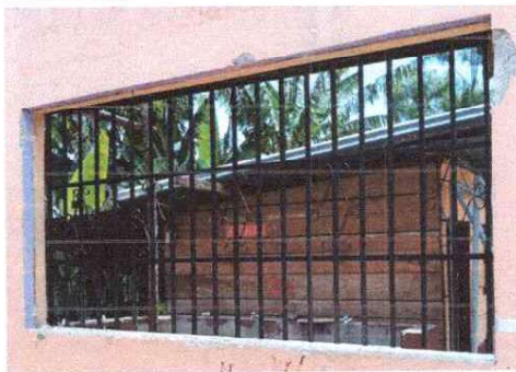
Foto 3: Desinstalación de 2 ventanas de aulas si ventilación
