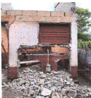
Foto 5: Modulo 5: Ventanas de madera en remodelación por deterioro.
